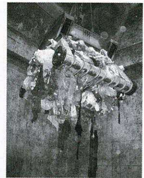
RDF施設に搬入されたゴミをクレーンでかくはん
