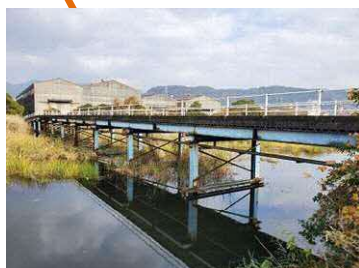
小島橋 (鋼橋) L=95.0m 1991年架設
