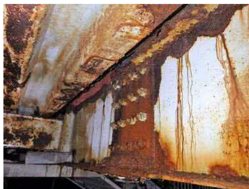
主桁の腐食
