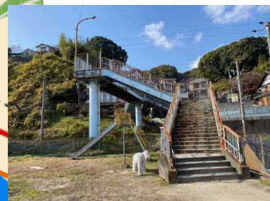
城山陸橋 (鋼橋) L=41.4m 1964年架設
