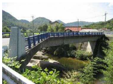
栄橋 (PC橋) L=42.5m 1998年架設
