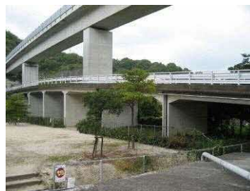
玖波9号線1号橋 (RC橋) L=66.1m 1985年架設
