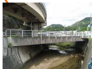
小方橋 (PC橋) L=24.8m 1982年架設
