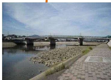
大和橋 (PC橋) L=107.6m 1997年架設
