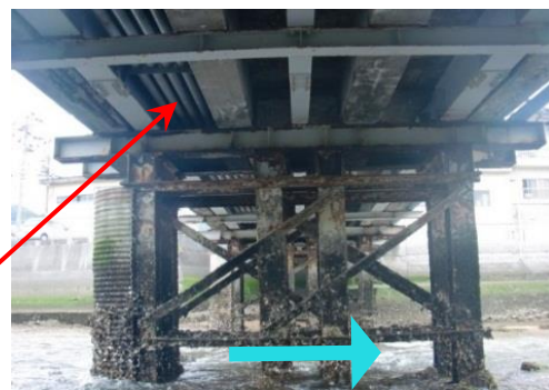
写真2 → (床版下面・橋脚)
