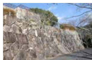
復元された石垣。城のある山が亀の伏した形に似ていたことから、亀居城と呼ばれるようになった。
