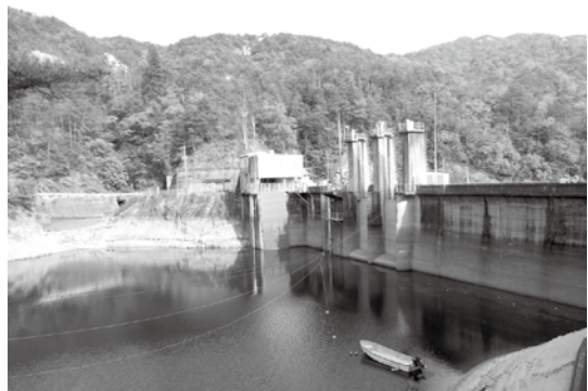
【渡ノ瀬ダム】廿日市市大野にあり、昭和31年3月に完成。堤高34.5mの重力式コンクリートダムで総貯水容量が1,043万4千㎡となっている。目的は、水力発電。
