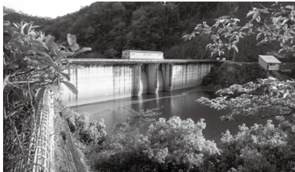
【小瀬川ダム】岩国市美和と廿日市市浅原の境にあり、昭和40年3月に完成。堤高49mの重力式コンクリートダムで、総貯水容量が1,140万㎡となっている。目的は、洪水調節や工業用水道供給、水力発電など。
