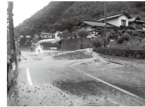
木野2丁目 土砂流出状況
