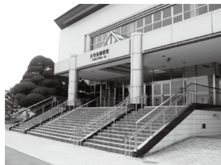
正面階段手すり・スロープ
