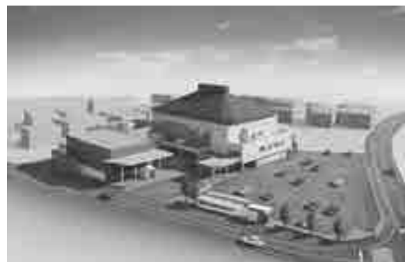
現在工事中の大竹会館。アゼリアホールに連結する新築棟は、市民活動拠点・支所・公民館・防災機能などをコンパクトに集約した施設となります。
