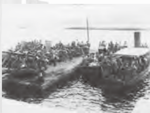
外地からの引き揚げを受け入れた大竹港。
