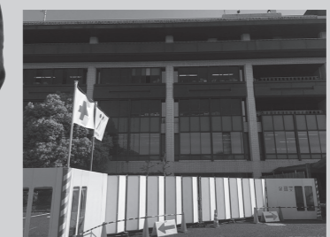
◀耐震化工事のため、南玄関側駐車場の一部が利用できません。事務室の移動などもあり、ご不便をおかけしています。
