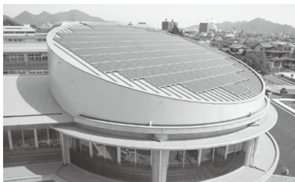
(上)屋上に設置された太陽光パネル
