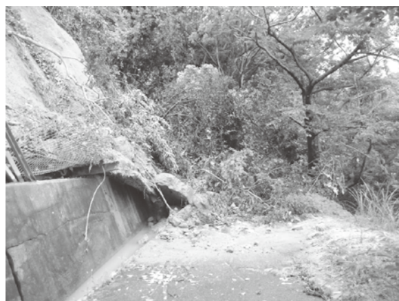
大雨によるがけ崩れ
