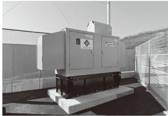
災害に備えて自家発電機を設置
