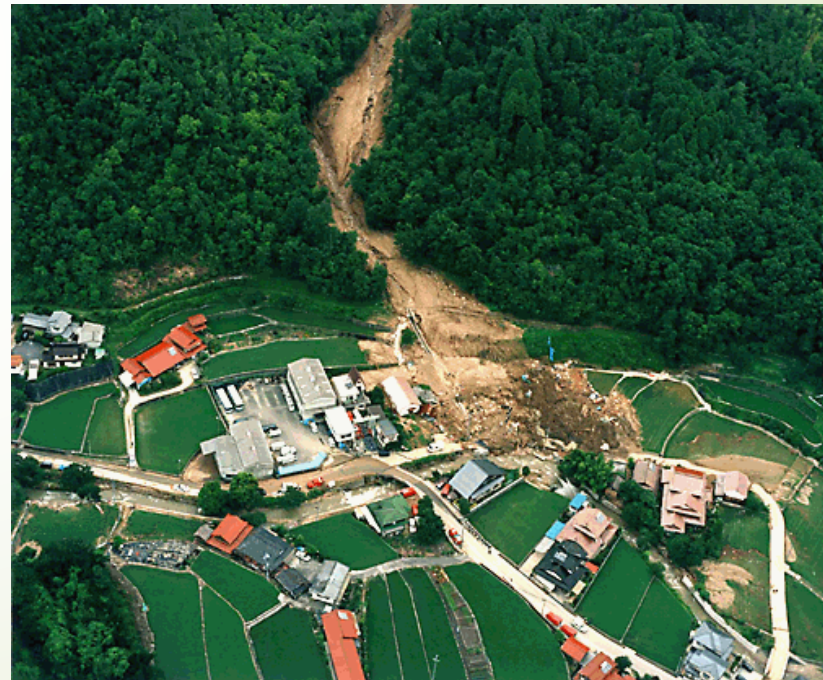
大毛寺川左支川 氾濫状況 (航空写真)
