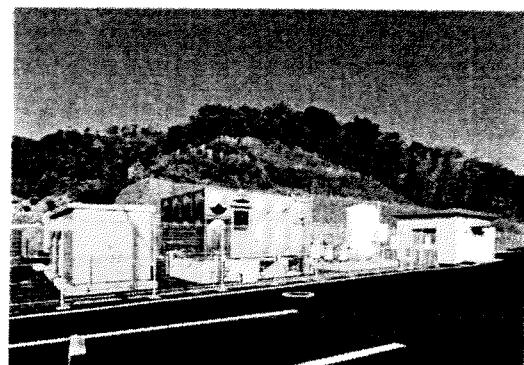
貯水槽・備蓄倉庫
