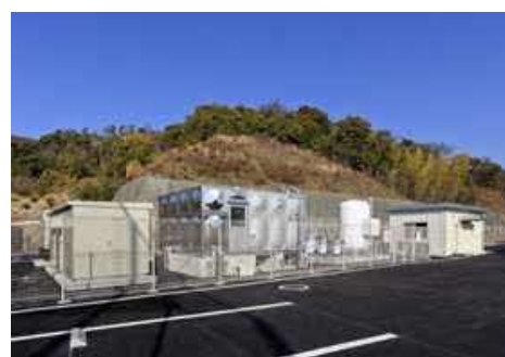
貯水槽・備蓄倉庫
