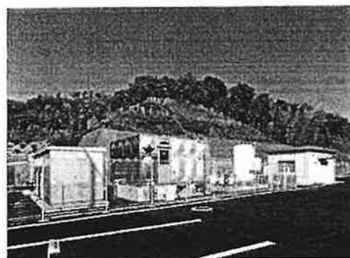
貯水槽・備蓄倉庫
