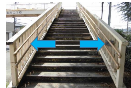
①対策後(陸橋の階段昇降部)
