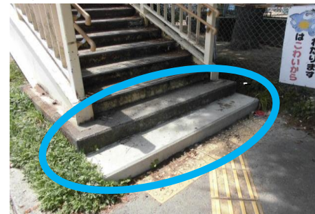
①対策後(陸橋の異なる段差部)
