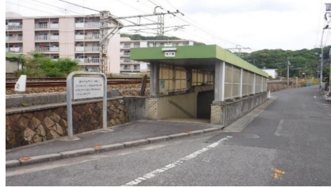
⑤対策前(小方1丁目 地下道入口)
