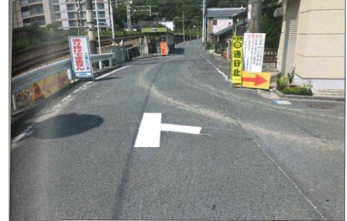
⑥対策後(小方1丁目 元市営プール付近)
