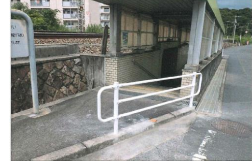
⑤対策後(小方1丁目 地下道入口)
