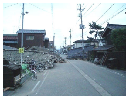
▲阪神・淡路大震災による住宅の倒壊
