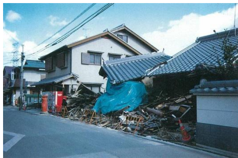
阪神・淡路大震災の建物被害例
