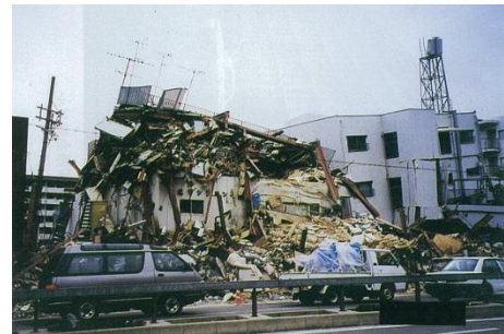
阪神・淡路大震災の建物被害例
