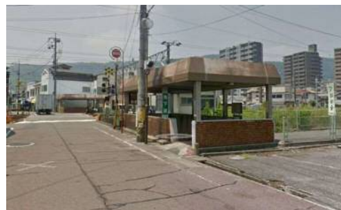
郷水第2踏切南側地下道
