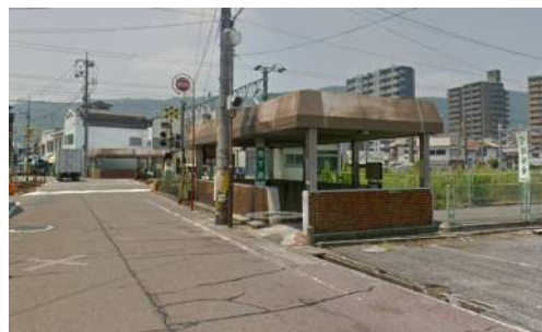
郷水第2踏切南側地下道
