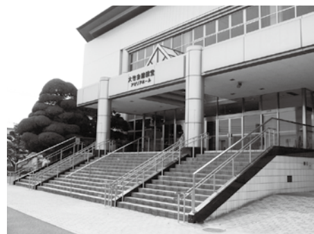
正面階段手すり・スロープ
